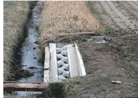
魚道等水路の設置
